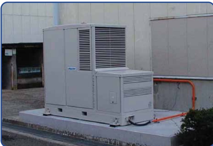
社内に設置された5kW 定置型PEFC試作機(クボタ)
