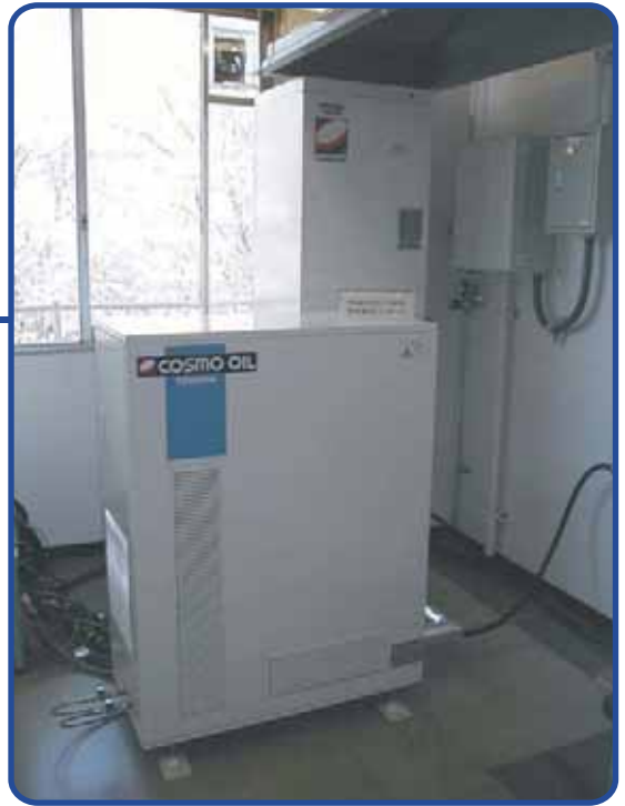
ブタン燃料の 1 kW 級家庭用燃料電池 (PEFC) (コスモ石油)
